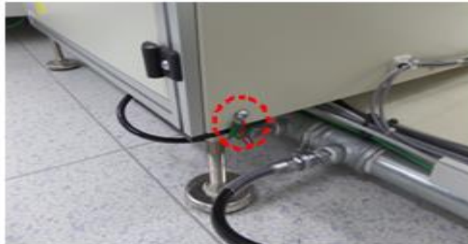
Nối đất bên ngoài thiết bị sản xuất
