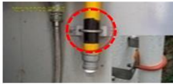
Dán Tape cách điện vào phân cô định đường ống và chông rỉ sét đường ống
