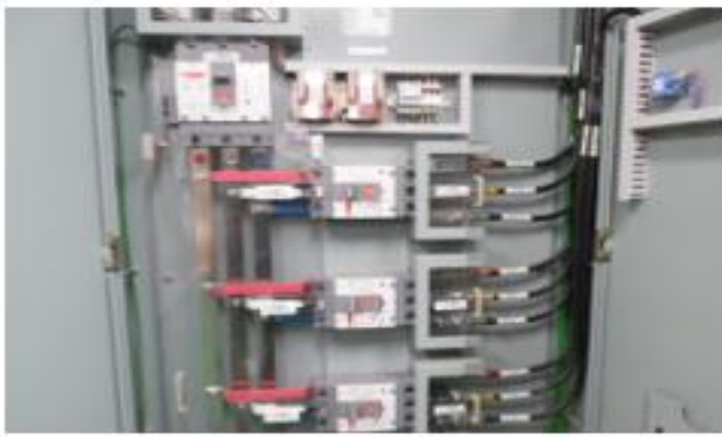
Lắp cover an toàn cho tủ điện
